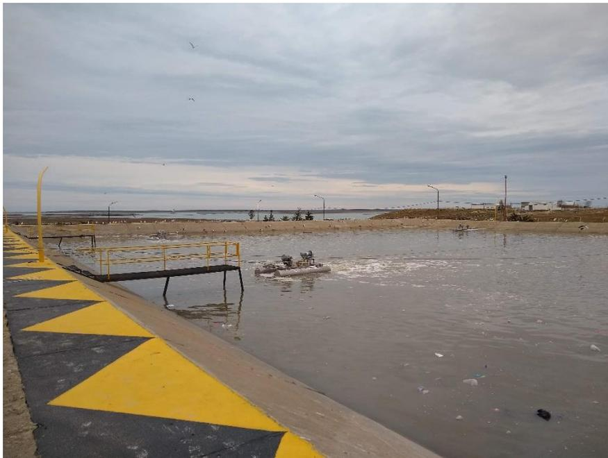
**Figura 5.1.** Pileta de aireación en funcionamiento de la Planta de tratamiento cloacal de Puerto San Julián, agosto de 2022.
