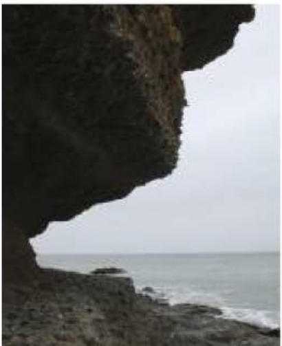
Figura 4: Acantilados erosionados en la base por la acción del oleaje.
