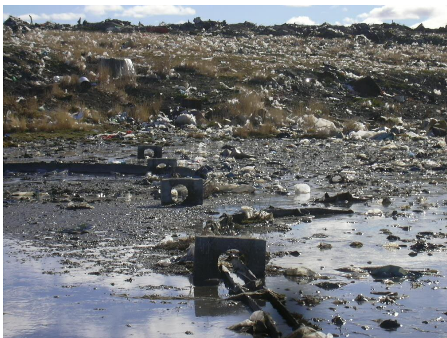
Emisario roto del efluente cloacal de la planta de tratamiento.
